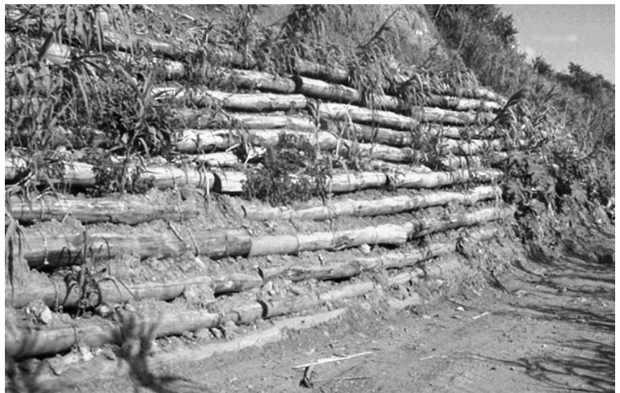
Fig. 4. Esempio di applicazione degli elementi a Fuscaldo (Cosenza) dove a monte della S.S. 18 sono stati installati 70 elementi del prototipo 2 su due allineamenti sovrapposti. Data la grande presenza d'acqua nel sito, a tergo degli elementi sono stati installati in direzione longitudinale tubi microfessurati drenanti (diametro 200 mm) protetti con geotessuto, integrati con elementi drenanti trasversali alla base degli elementi.
