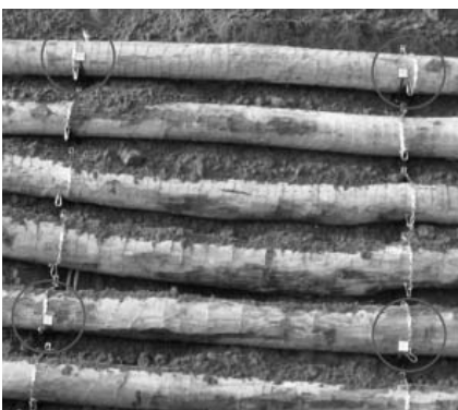
Fig. 14. Posizione delle mire topografiche sulla struttura (prototipo 2). Positioning of the targets for topographical measurements (prototype 2).
