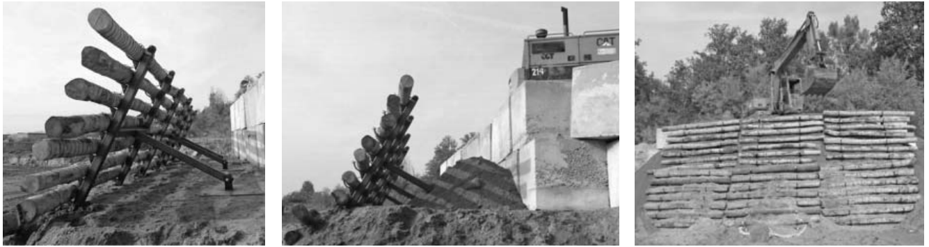
Fig. 3. Realizzazione del campo prove del prototipo I. È possibile vedere il dettaglio delle fasi di riempimento dello stendimento superiore.
